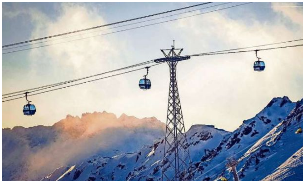
In der Saison 2027/2028 soll die neue Schiferbahn in Betrieb genommen werden.
